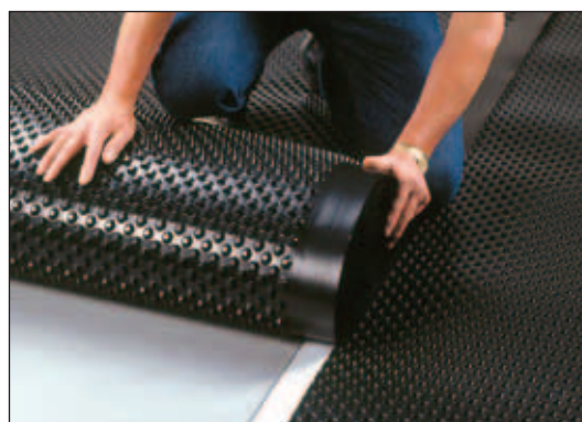
Rychlá a jednoduchá instalace pro překrytí izolované suché konečné úpravy podlahy nebo překrytí s konvenčním vyrovnávacím potěrem podlahy.
